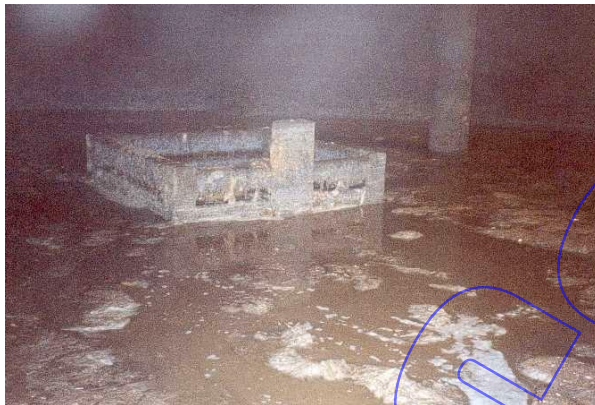
Abb. 5: Verschlammte Beckensohle
