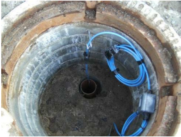
Abb. 10: Installation einer Drucksonde
