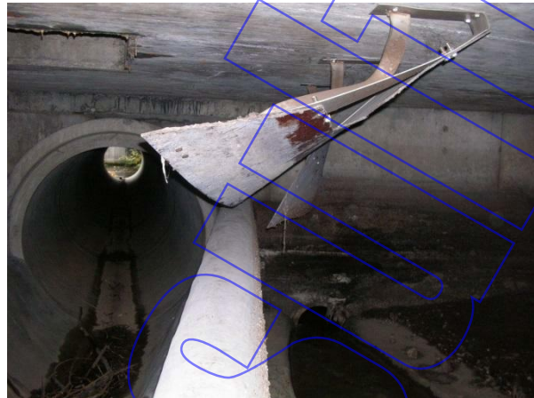
Abb. 4: Verbogene Tauchwand
